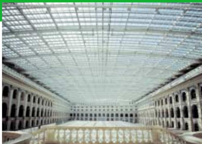
Nouveau centre commercial *Gostiny Dvor* à Moscou, comprenant 4000 m<sup>2</sup> de verre *Eglass* et dont les parois intérieures sont recouvertes de panneaux acoustiques *Ecophon*.
