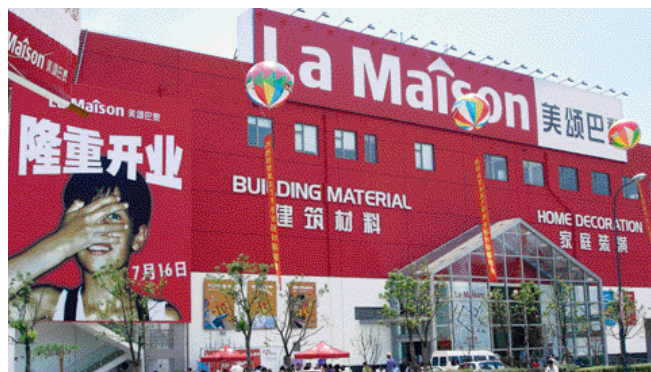
Saint-Gobain Distribution a ouvert en 2005 à Shanghai un nouveau concept de distribution pour l'aménagement intérieur : « La Maison ». Le magasin, ouvert 7 jours sur 7, regroupe sur 6 000 m 2 deuxtages, un show-room et un libre-service technique. Une salle d'exposition présente au premier étage 50 ambiances du sol au plafond.
