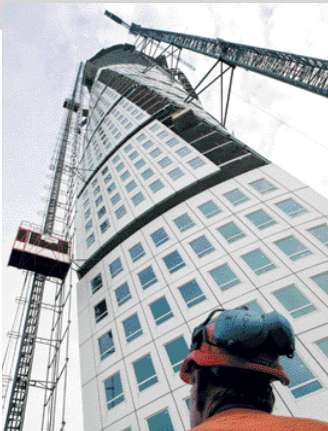
20 000m 2 de produits Isover ont été livrés pour ce bâtiment suédois de 190 mètres, tournant sur 90 degrés de bas en haut.
