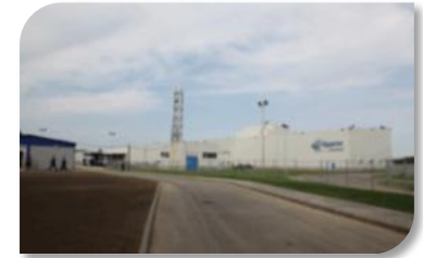
Usine de plaques de plâtre de Gomzovo en Russie
