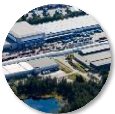
Centre logistique pour la Distribution dans les pays nordiques
