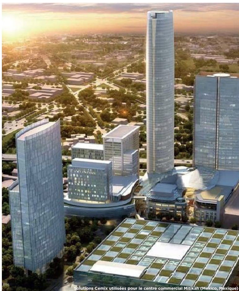
Solutions Cemix utilisées pour le centre commercial Mitikah (Mexico, Mexique)
