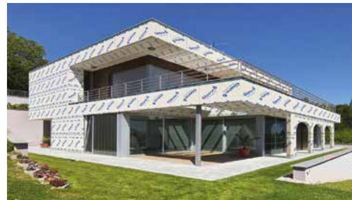
Glasroc X est une solution proposée par Rigips, qui combine un voile non tissé Adfors avec une plaque Gyproc et offre des bénéfices de protection contre l'humidité, à l'intérieur comme à l'extérieur. Cette solution est complétée par l'application de mortiers mis au point par Weber.
