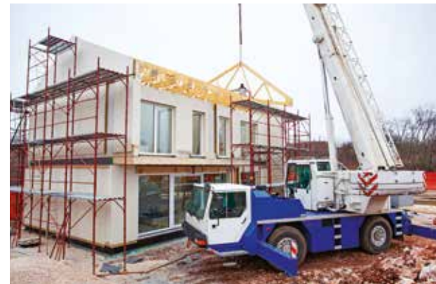
La préfabrication réduit significativement les déchets et la durée des chantiers de construction.
