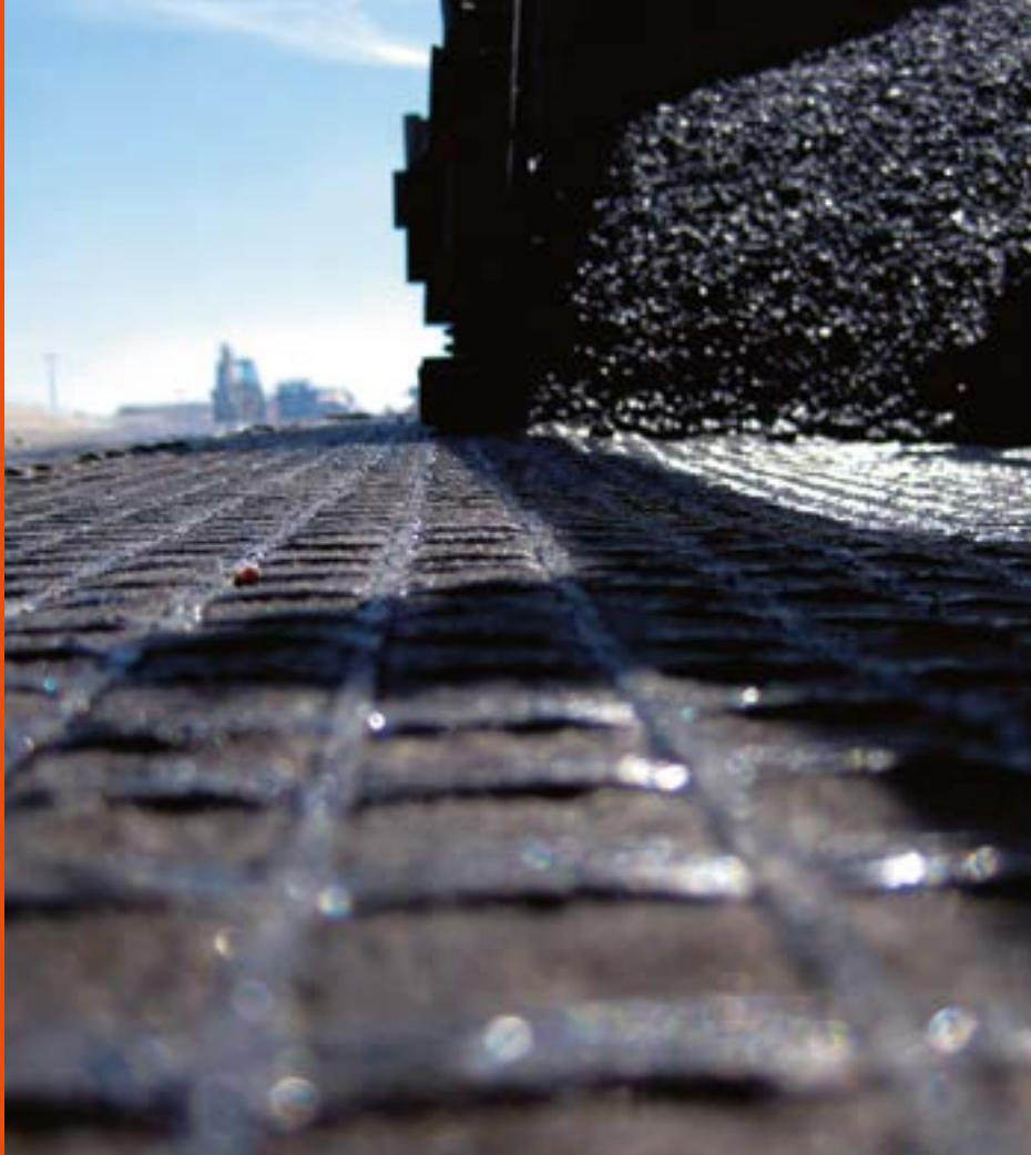
Les grilles de renfort GlasGrid® de Saint-Gobain Adfors protègent les routes bitumées, les pistes d'aéroport et les ponts contre les fissures.
