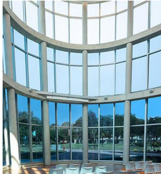
**Sage Glass@** : verre électrochrome développé initialement par Sekurit pour Ferrari puis adapté aux marchés de la construction
