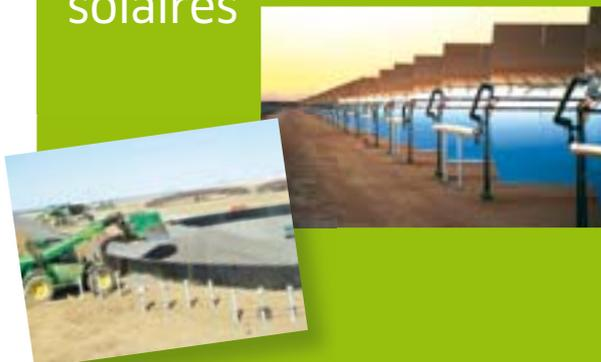
Grâce à ses propriétés d'isolation, d'inertie, de résistance au feu et de résistance mécanique, l'argile expansée, facile à manier du fait de sa légèreté, est un excellent matériau pour protéger et recouvrir les cuves de stockage d'eau chaude. Ce produit est notamment utilisé pour les fermes solaires.
