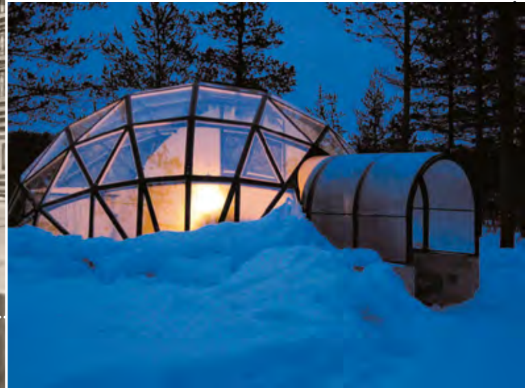
2009 Finlande Les vitrages chauffants de l'hôtel Kakslauttanen à Saariselkä.
